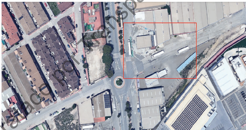
IMAGEN 1: FALTA DE MARCAS VIALES
